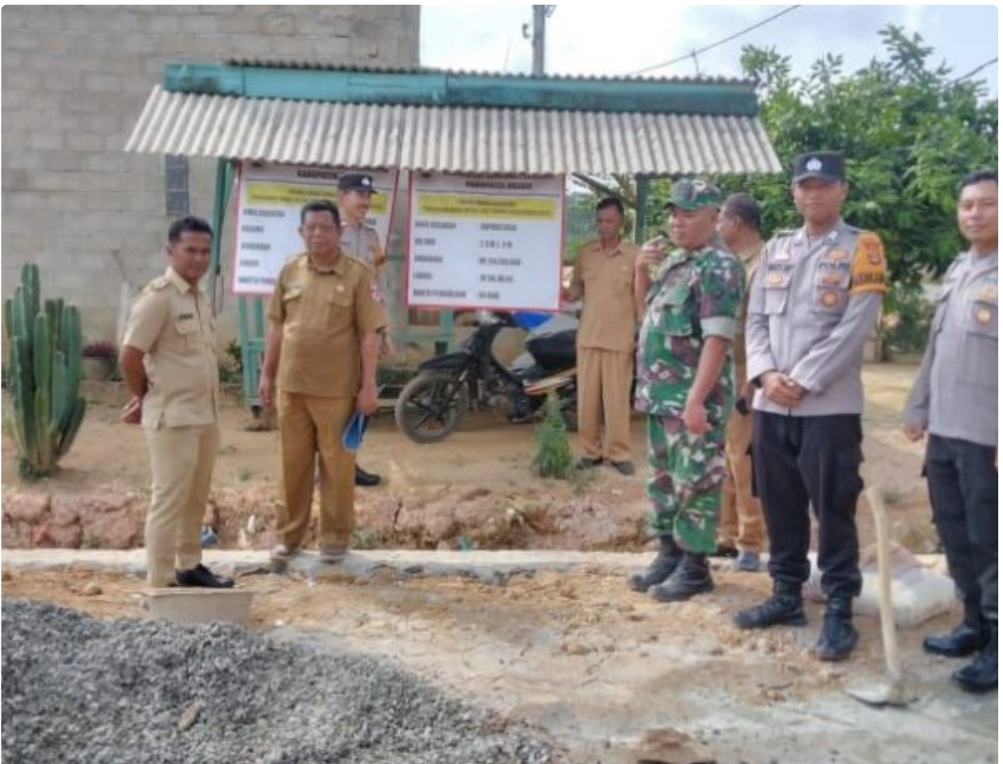
Pembangunan Gapura Desa Aji Jaya
