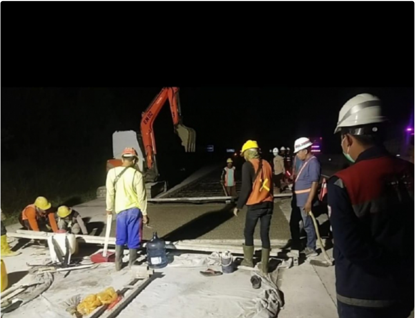
PT HKI Perbaiki Tol Terbanggi Kayu Agung
